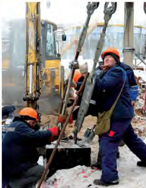
В кадре – перенос опоры для дымовой трубы котла
